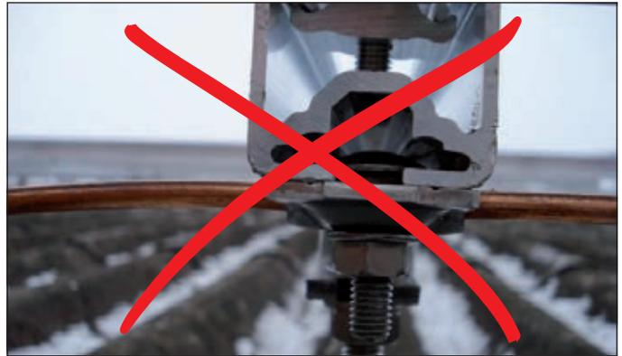
Integrazione nel sistema di protezione da fulmini. Linee di captazione in rame nudo sono collegate ai profili di alluminio mediante terminali in acciaio inossidabile.
