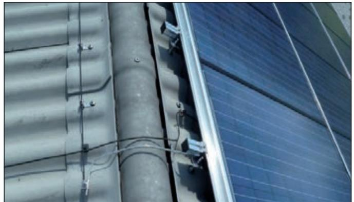
Collegamento delle guide profilate di alluminio con terminali di contatto per guide profilate. Materiale dei terminali di contatto acciaio inossidabile (nessuna corrosione da contatto).
