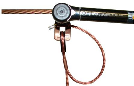
2. Fixation des attaches pour les pendules à câbles au fil de contact. Serrer la vis avec 25 Nm.
