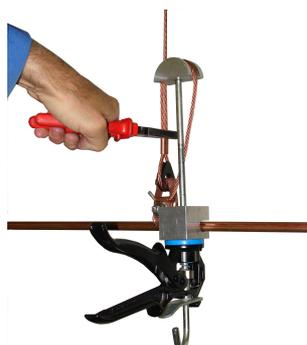
8. Pressage de la douille de serrage avec la matrice à sertir (type DB 10 K ).
